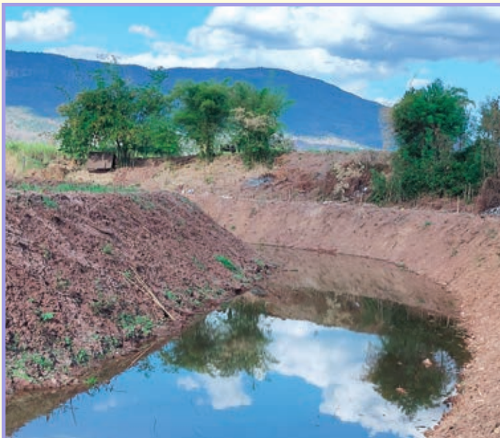
15. ขุดลอกลำห้วยกุ่ม บ้านห้วยกุ่ม 2 หมู่ที่ 14 ตำบลนางแดด - บ้านหนองกุง หมู่ที่ 7 ตำบลหนองแวง อำเภอนางบัวแดง จังหวัดชัยภูมิ
