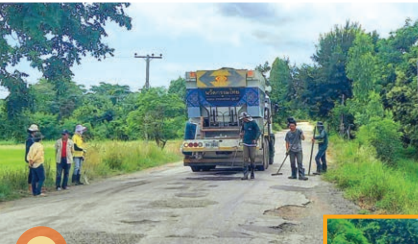
13. โครงการปรับปรุงถนนลาดยาง รหีสทางหลวงท้องถิ่น ชย.ถ.1-0102 บ้านเขว้า - บ้านหนองบัวบาน อำเภอบ้านเขว้า จังหวัดชัยภูมิ
